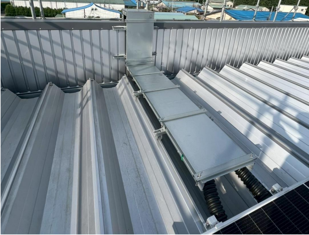
○ラック・配管工事
